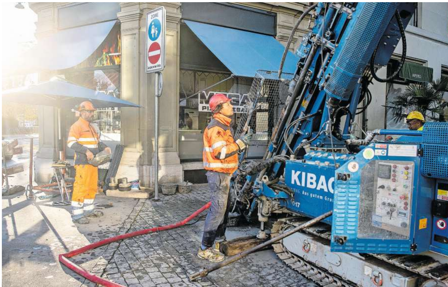
Sondierbohrungen laufen an der Ecke Halden-/Stiftstrasse, in der Nähe der Hofkirche.
