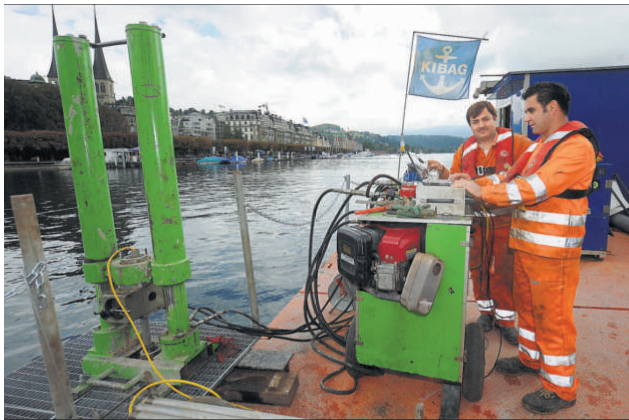
Spezialisten treiben durch die grünen Rohre eine Messsonde in den Grund des Seebeckens. Bild Boris Bürgisser
